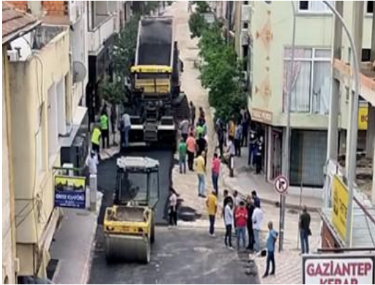
Turgut Özal Ve Andırın Caddesi Sıcak Asfalt Çalışması
