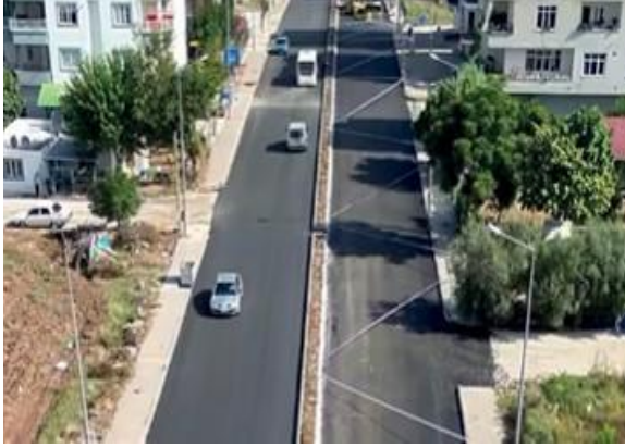
Hastane Yolu Sıcak Asfalt Uygulaması
