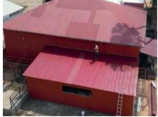
Mezbahane Tadilat Çalışmaları
