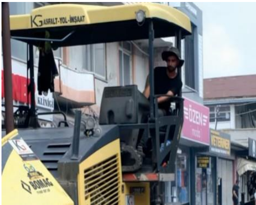
Eski Sanayi Caddesi Asfalt Yol Çalışması Asfalt Dökümü
