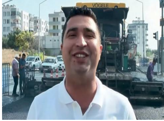
Alparslan Türkeş Bulvarından Tokilere Kadar Sıcak Asfalt Uygulaması
