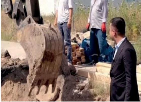
Alparslan Türkeş Bulvarında Köprü Geniştirme Çalışmaları
