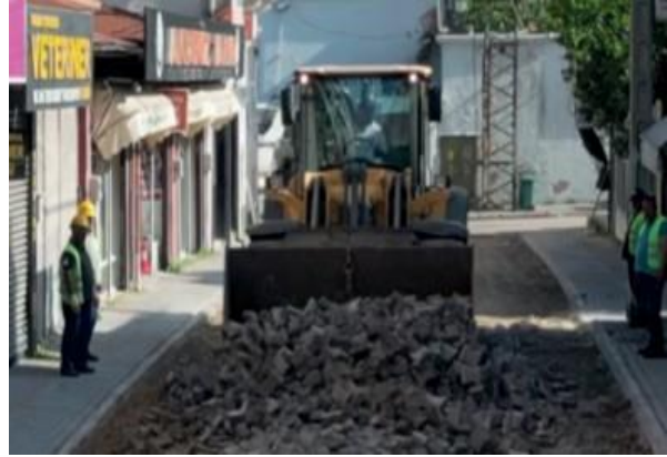
Eski Sanayi Caddesi Asfalt Yol Çalışması Parke Sökümü
