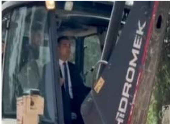
Sülemiş Yürüş Yolunda Büfe Yapımı Temel Atma
